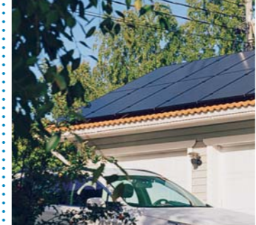
Parhaimman tehon saa suuntaamalla paneelit etelää kohti. Meidän leveysasteillamme paneelit eivät tuota marras-tammikuussa melkein mitään, mutta pilvttömissä ja vähälumisissa olosuhteissa tuotanto lähtee käyntiin helmi-kuun puolivälissä.
