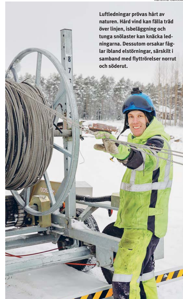
Herrfors-Näts linjemontörer Mikael Peldan och Tuomas Keränen tar ner den uttjänta luftledningen i Eugmo.
