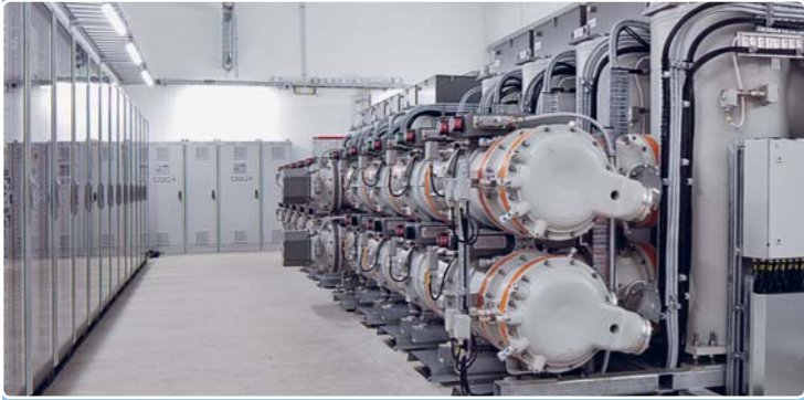
Pärbilden är inifrån GIS kopplingsstationen vid Jussila.
